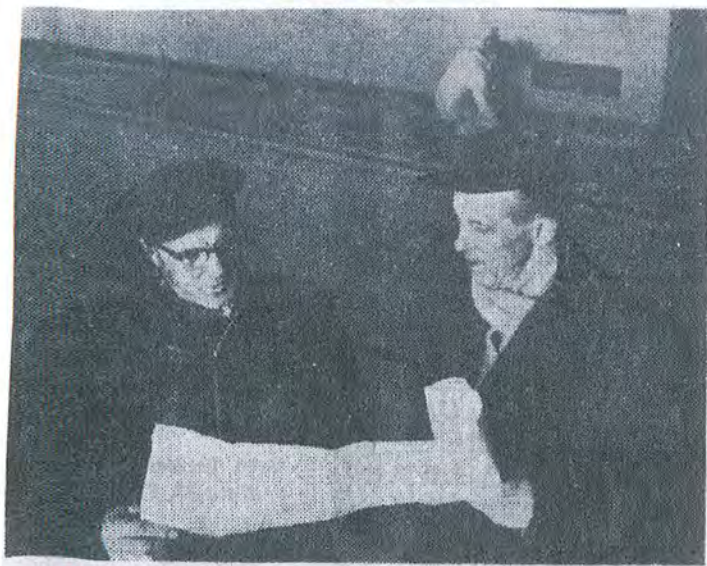
Skolbyggnadskommitténs ordf. Carl-Arvid Zennström diskuterar en ritningsdetalj med verk. Olle Westlund. I bakgrunden den nya skolan med grönt kakel beklädda simbassängen.
