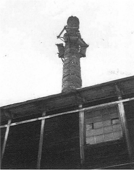
Murarna på väg upp mot toppen för att riva skorstenen, 1944.
