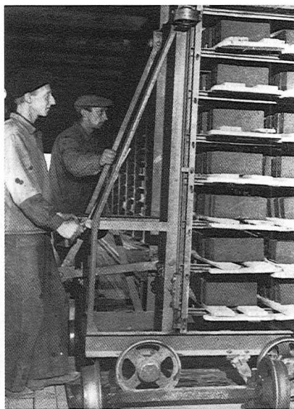
Insättning av tegel i Nybruket för torkning 1950.
