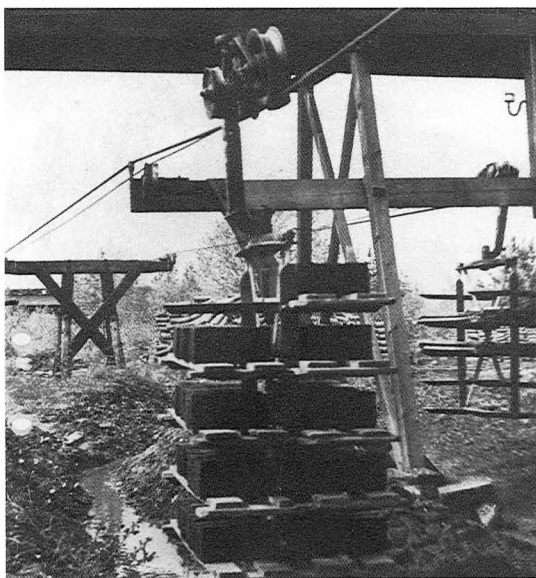
En linbanevagn med nyslagent tegel på väg mot Nybruket 1950.
